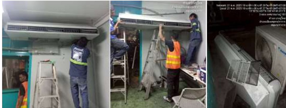
ก่อนปรับปรุง (ก่อนทำการเปลี่ยนแอร์ตัวเก่า)
